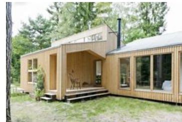
400 digitalt producerede moduler af FSC certificeret konstruktionsfinér. Illustration EENTILEEN.
